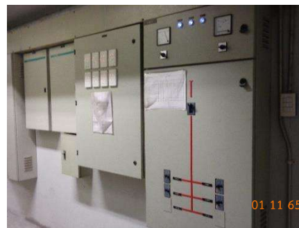
รูปที่ 2-30 อุปกรณ์เปิด-ปิด ระบบแสงสว่างอัตโนมัติ บริเวณพื้นที่สาธารณะของโครงการ
