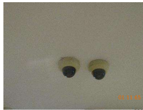
รูปที่ 2-12 กล้องโทรทัศน์วงจรปิด บริเวณโถงทางเดินหน้าลิฟต์โดยสาร
