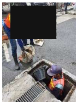
รูปที่ 2-25 การทำความสะอาดรางระบายน้ำ ภายในโครงการ
