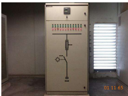
รูปที่ 2-35 อุปกรณ์ควบคุมค่าเพาเวอร์แฟคเตอร์
