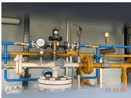
รูปที่ 2-43 อุปกรณ์ตรวจจ่ายก๊าซบริเวณถังเก็บก๊าซหุงต้ม ของพื้นที่ส่วนกลาง
