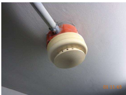
รูปที่ 2-37 อุปกรณ์ตรวจสอบจับความร้อน
