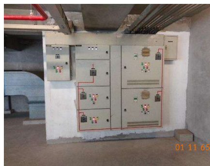
รูปที่ 2-34 อุปกรณ์ควบคุมความเร็วรอบของระบบพัด ลม
