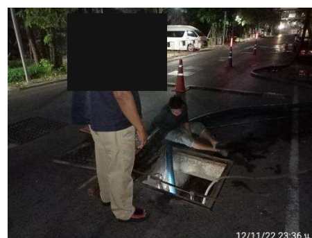
รูปที่ 2-23 การสูบน้ำจากตะกอนในถังเกรอะ
